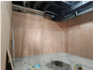
01 · WALL PLY INSTALL
